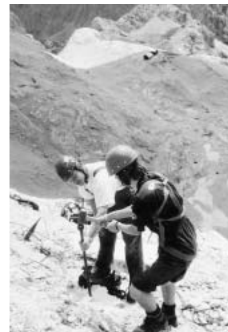
Med montažo kovinskih varoval na pobočju Triglava.
